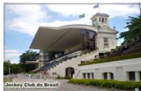
A arquibancada do Pavilhão Principal teve por muitos anos o maior vão central em concreto armado da América.
